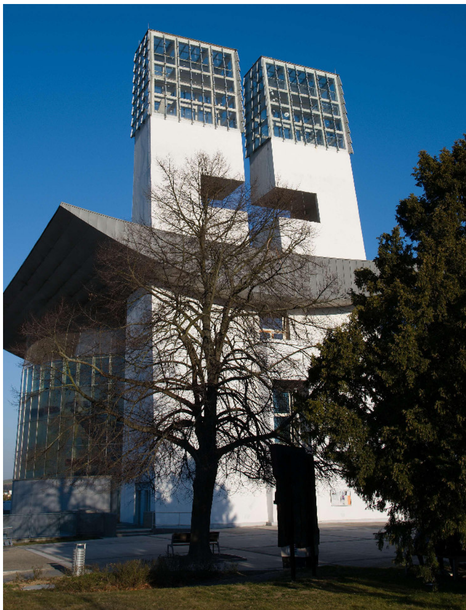
POHLED - STÁVAJÍCÍ STAV
